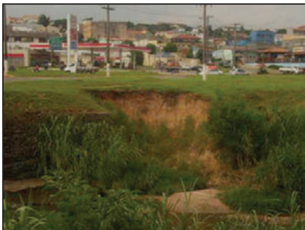
Figura 6. Atuação intensa dos processos erosivos implicando na perda do solo urbano e no alargamento do talvegue com conseqüente assoreamento em virtude do material depositado
