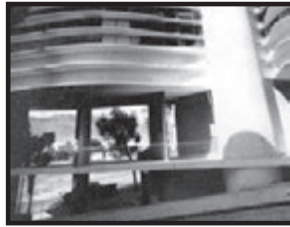
Figura 12. Fotografía (fragmento) que muestra detalles del pórtico del Edificio Niemeyer, con la Sierra del Curral al fondo. Año 1963
