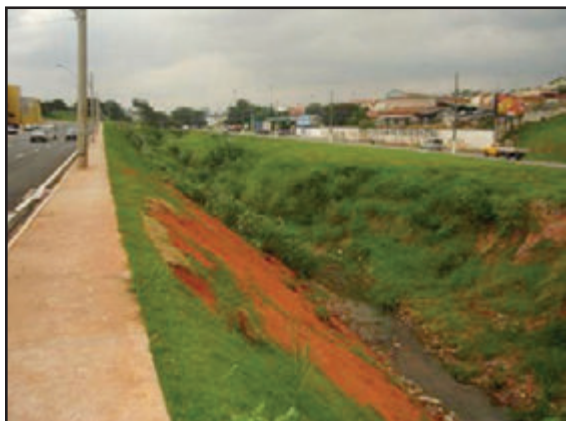
Figura 7. Ausência de mata ciliar e atuação dos processos erosivos tendendo ao escorregamento das encostas e às perdas de solo urbano
