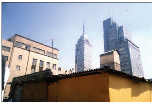
Figura 5. “Jacales” en la azotea del Edificio López 23
