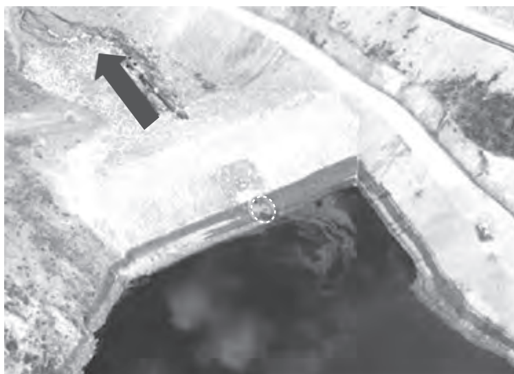
FIGURA 7 Cortina del represo que falló (vista de planta)
