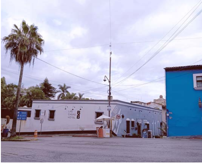
Fotografías del autor. Vista desde Calle Fray Bartolomé de las Casas esquina con Boulevard Benito Juárez (octubre de 2024).
